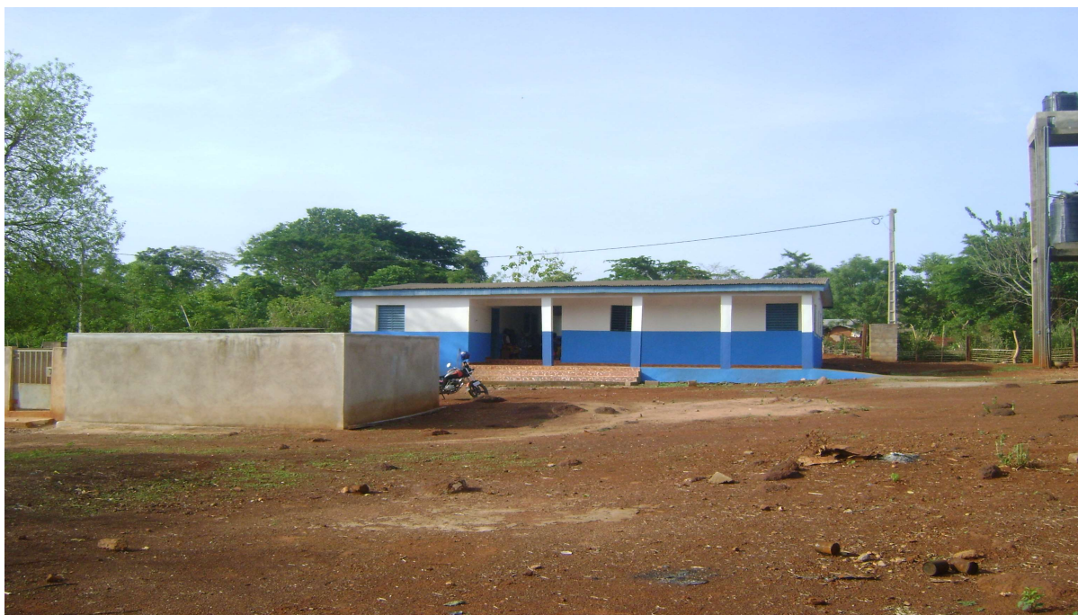
Il dispensario con la torre dell'acqua (altezza 10 metri, capacità 14 tons), e davanti i ripari in muratura per la pompa elettrica e i pannelli solari
